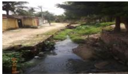
Vista do canal na rua Dr. Procópio
