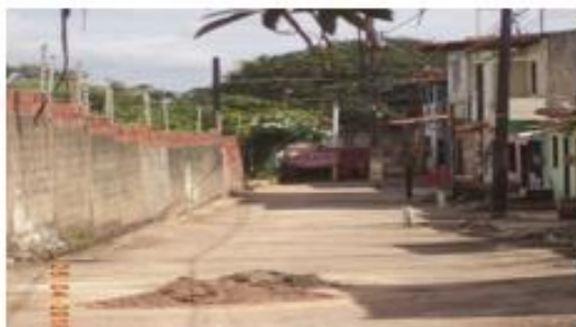
Área da possível EEE no final da rua Dr. Procópio
