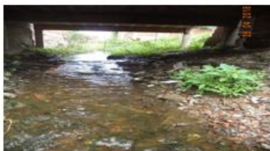
Vista do canal na rua H
