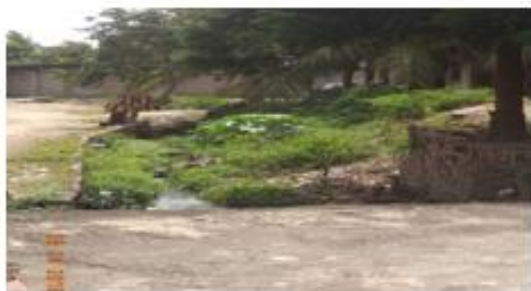
Vista do canal na rua Dr. Procópio
